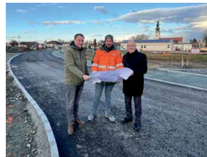
Bei der Baustellenbesichtigung Ende November: Wirtschaftshof-Leiter DI Markus Imre BSc, Michael Rosner und Bürgermeister Georg Rosner (v.L.)
