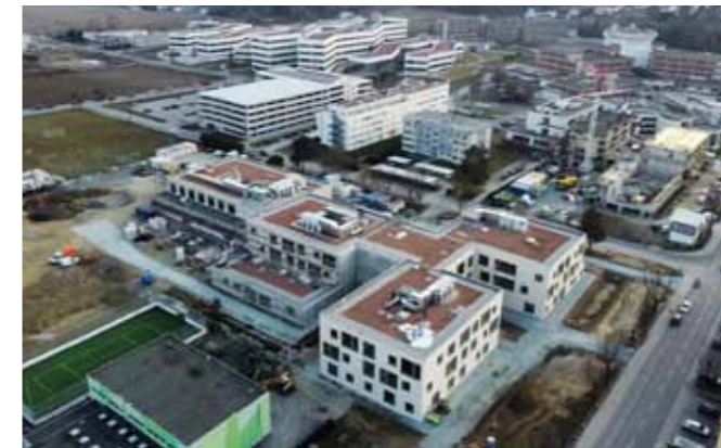
Baustelle Bildungscampus. Die Drohnenaufnahmen zeigen eindrucksvoll, wie groß der Komplex des neuen Schulgebäudes ist. Die Arbeiten laufen nach Plan, schon im Herbst können Volksschule, Zentralmusikschule und Stadtrappele die neuen Räumlichkeiten beziehen.
